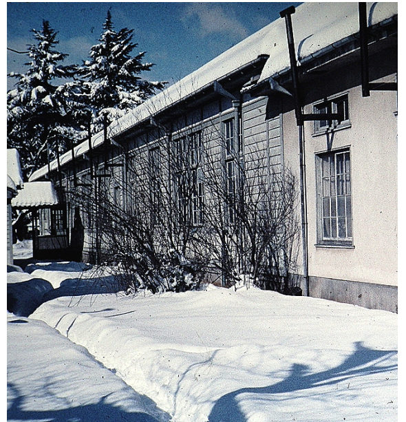
▼写真① 松本市県にあった文理学部の校舎は旧松本高校から引き継いだ木造。冬には薪によるダルマストーブで暖を取りました
